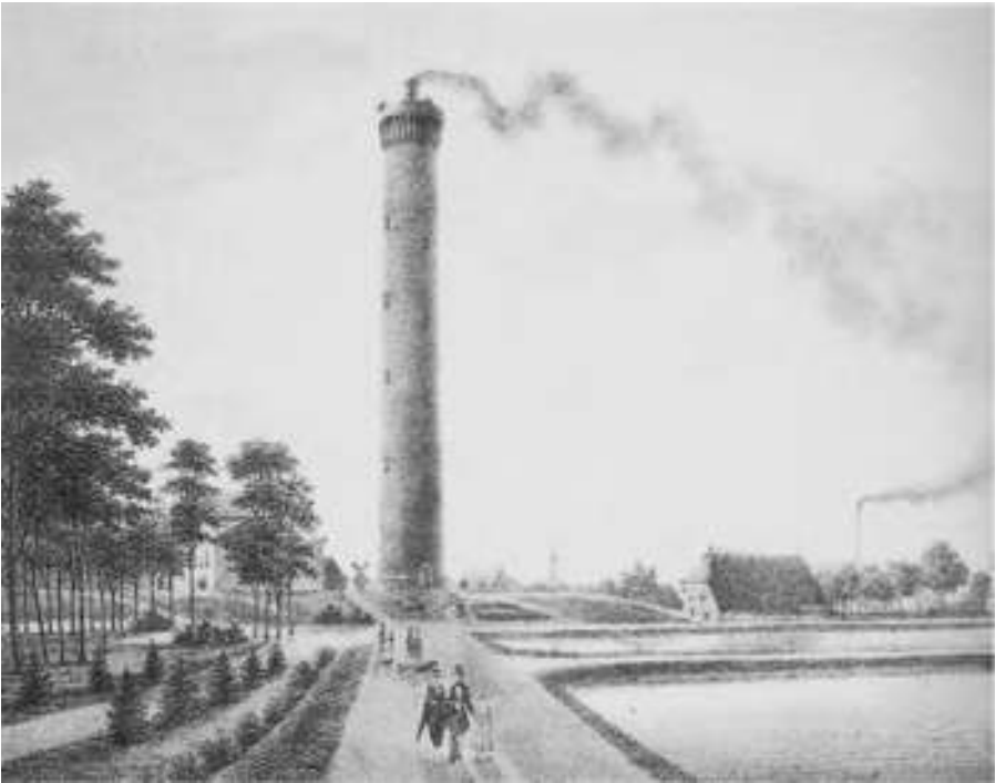
Der 65 bzw. 73 m hohe Wasserturm Rothenburgsort in der Bildmitte, das Pumpwerk hinter den Bäumen hinten links und die drei Ablagerungsbecken rechts im Bild. Lithographie v. Peter Suhr, um 1848
