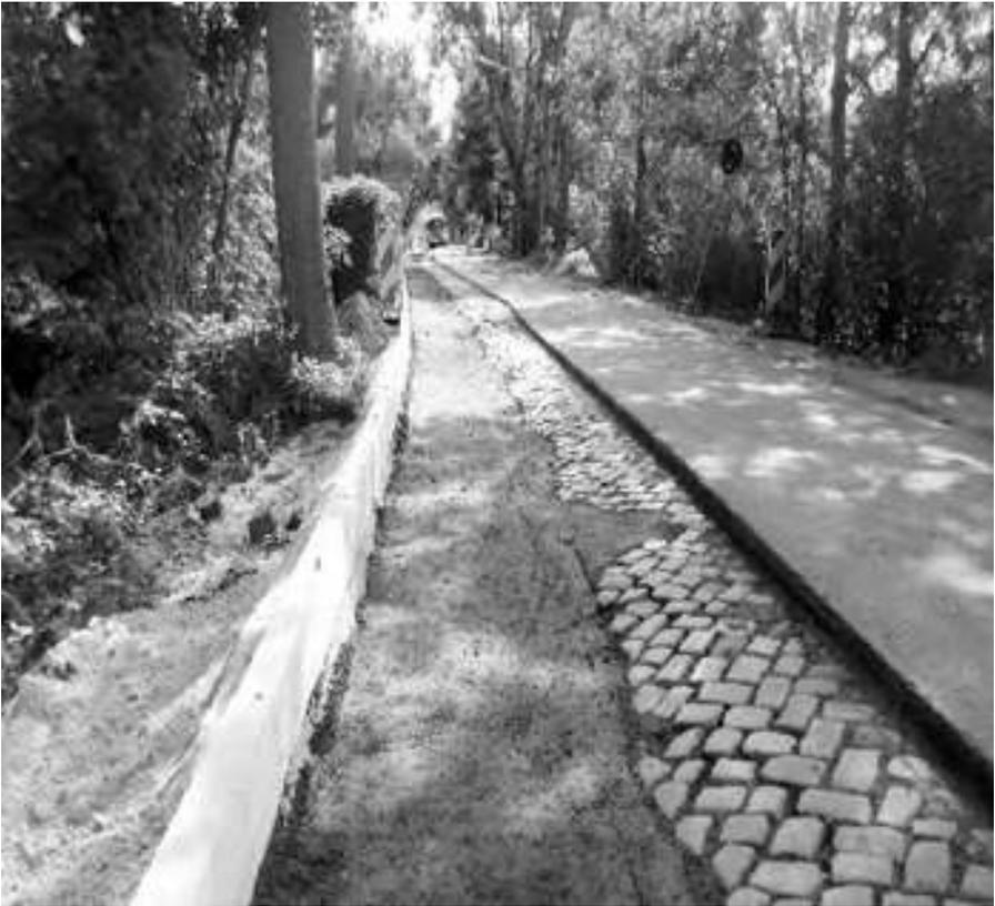
Gehörige Massen an Materialien waren für die Arbeiten erforderlich: unter anderem 3.100 to Asphalt verschiedenster Spezifikation, mehr als 4,5 km Bordsteine, Sand, Kies, Mutterboden; rund 1.000 qm Grundstücks- und Ackerzufahrten wurden zudem neu hergestellt und angepasst.
