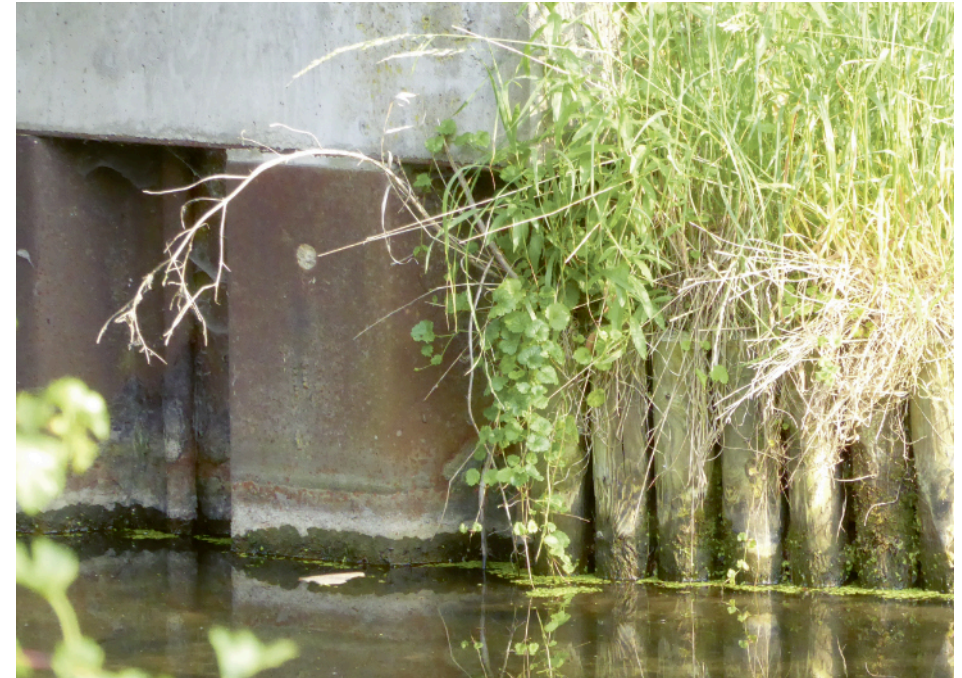
Brückenlager Billebrücke Kreisel Mittlerer Landweg, der niedrigere Wasserstand ist gut zu sehen
